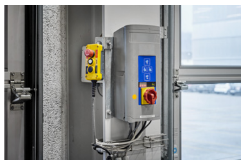
3 I comandi immurati o provvisti di bordi resistenti sono protetti contro gli urti di veicoli.
