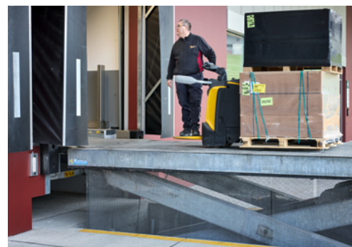
5 Coperture di protezione appropriate evitano che le persone non addette (ad es. bambini) possano entrare nella zona di pericolo sottostante alla piattaforma di sollevamento.
